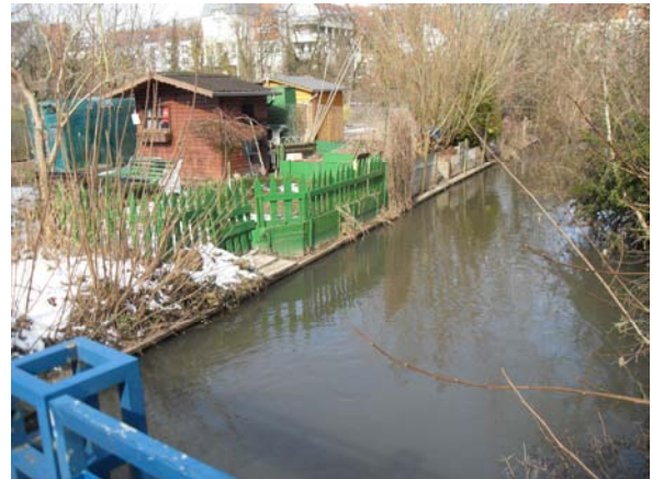
Bild 18: bestehender Kraichbach bei der Unteren Mühlstraße. Ufersicherung durch Spundwände
