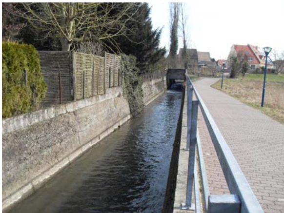
Bild 13: Mühlkanal, Blick gegen Fließrichtung. In Bildmitte ist der Auslauf aus dem Überleitungsbauwerk vom Kraichbach in den Mühlkanal zu sehen.
