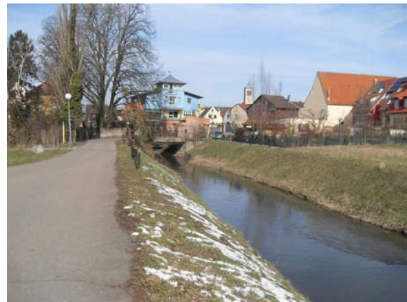
Bild 16: Kraichbach bei Bau km 0+800. Blick in Fließrichtung
