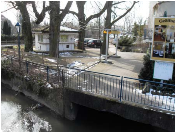
Bild 17: Einmündungsbereich des Mühlkanals. Der Einlauf wird abgemauert, die Überdeckung bleibt.
