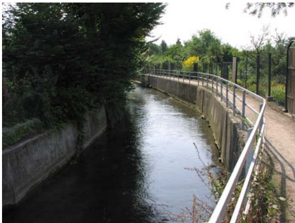
Bild 7: Blick gegen die Fließrichtung, rechts der bestehende Fußweg. Die Gehölze auf der linken Bildhälfte bleiben erhalten, die Ufermauer wird nur rechts z.T. abgebrochen
