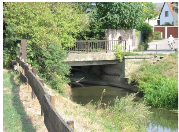
Bild 22: Kraichbach, Feldwegbrücke bei Flst.-Nr. 902/3
