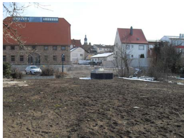
Bild 4: Blick vom best. Mühlkanal auf die beiden Schachtbauwerke und die neu errichtete Zehntscheune
