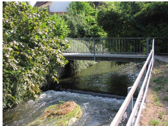
Bild 8: Blick auf einen der bestehenden Abstürze im Kraichbach. In diesem Bereich wird das alte Bachbett vollständig verfüllt.
