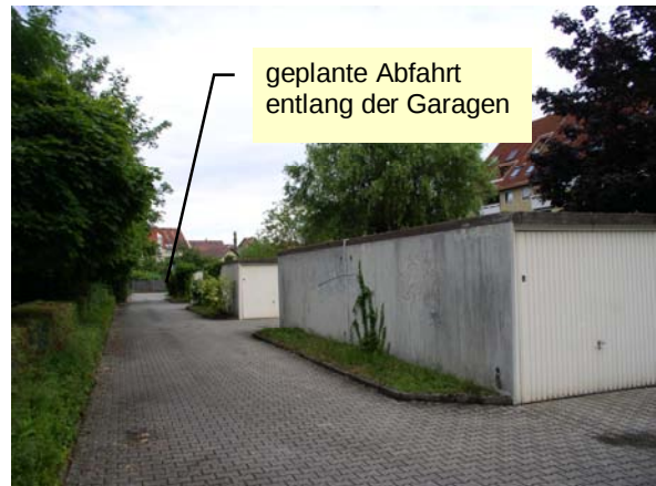
Bild 2: Blick entlang der Garagen, hier wird links die Gabionenwand errichtet (km 0+200)
