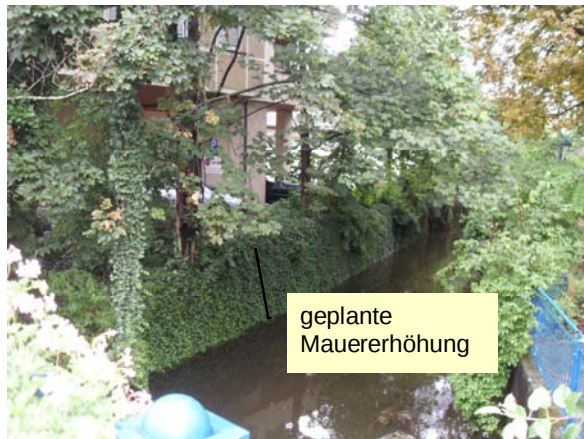
Bild. 1: Blick von der Karlsruher Straße gegen die Fließrichtung auf die zu erhöhende rechte Ufermauer (km 0+020)
