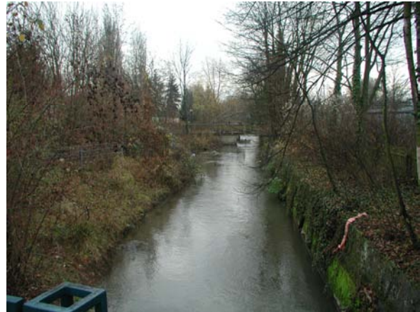
Bild 6: Mühlkanal, Blick von der Unteren Mühlstraße gegen die Fließrichtung auf den Wasserspielplatz, der im Zuge der Maßnahme rückgebaut werden muss.
