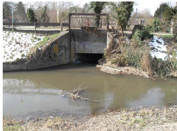
Bild 14: Kraichbach. Blick auf das Überleitungsbauwerk vom Kraichbach in den Mühlkanal
