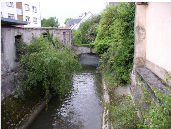
Bild 21: Kraichbach Blick auf die bestehende Bogenbrücke der Oberen Mühlstraße
