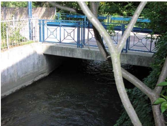
Bild 19: Brücke der Unteren Mühlstraße hier über den Kraichbach.
