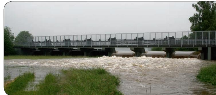
Abb. 20: Das HRB ist voll. Anhaltender Hochwasserzufluss kann nicht mehr gepuffert werden und wird vollständig über den Notüberlauf in den Sulzbach abgegeben (Juni 2013).
