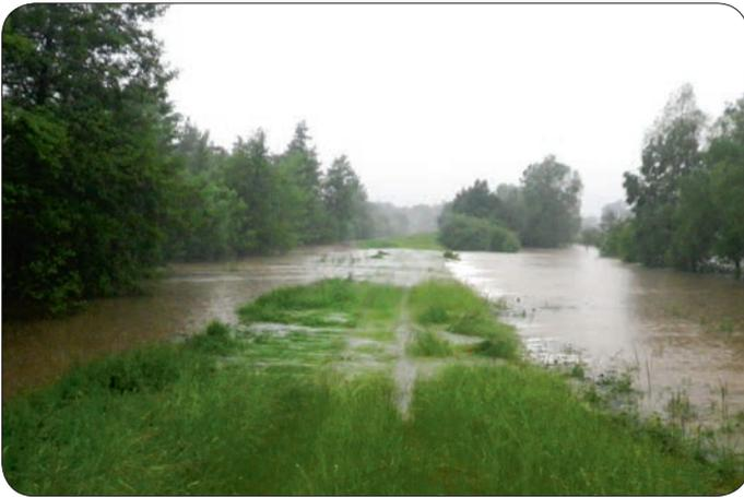
Abb. 17: Das Wasser fließt über den Überlauf Ü1 vom südlichen in das nördliche Becken (Juni 2013).
