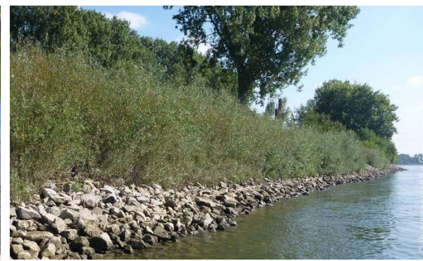
Böschungssicherung mit Steinschüttung (Quelle: BfG)
