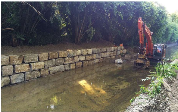
Böschungssicherung mit Blocksteinwand (Bildquelle: Nacken GmbH)
