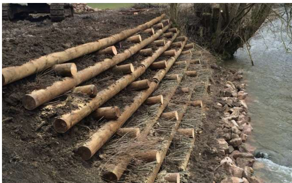
Böschungssicherung mit Krainerwand (Quelle: Freitag-Weidenart)
