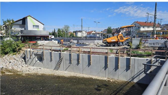
Bild: Die sanierte Hochwasserschutzmauer an der Pfinz in Söllingen
