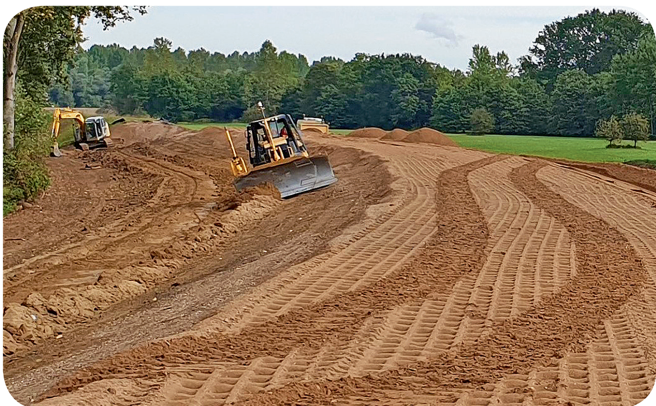
Ertüchtigung des Rheinhochwasserdammes
