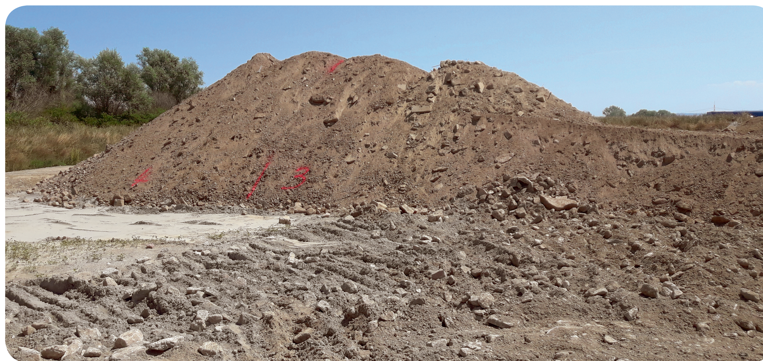
Abb. 3: gelagertes, zu Beginn der Baumaßnahme abgetragenes Dammmaterial (Foto: Ingenieurgesellschaft Kärcher mbH)
