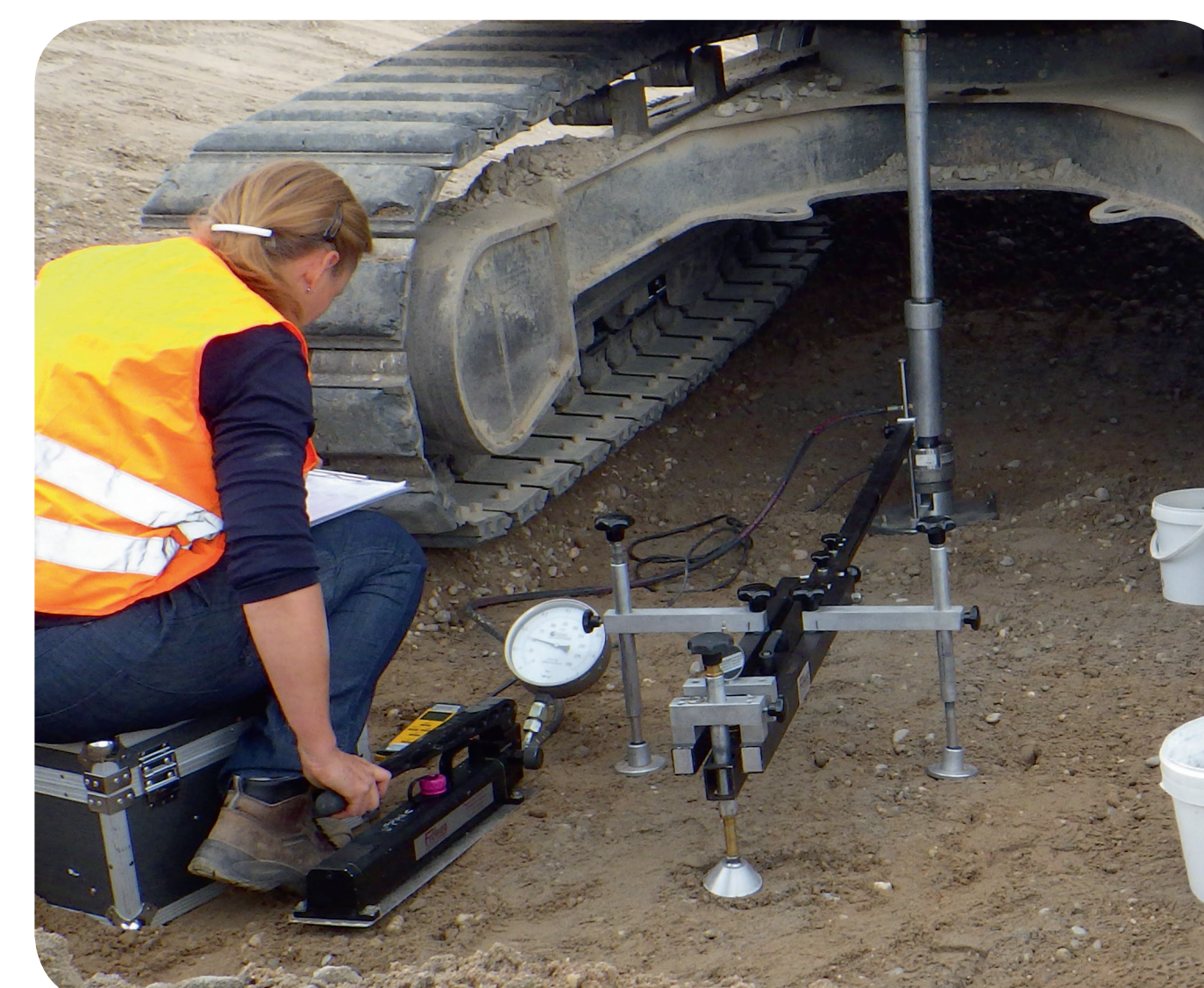
Abb. 2: Mit Hilfe eines statischen Plattendruckversuches wird die Verdichtung und Tragfähigkeit der Dammbaustoffe im eingebauten Zustand bestimmt (Foto: RP Karlsruhe)
