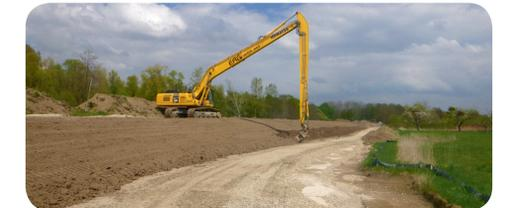
Wieder-Auftrag des zwischengelagerten Oberbodens auf den neuen Damm (Foto: solum - Büro f. Boden u. Geologie)
