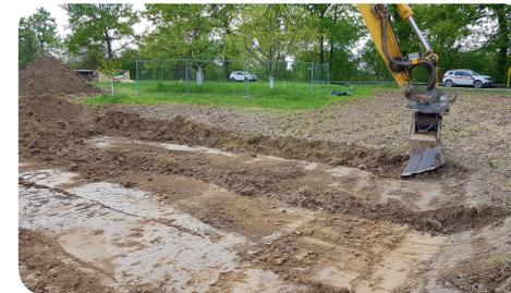
Fachgerechter Oberbodenabtrag ohne Befahrung des Bodens durch langen Baggerarm (Foto: RP Karlsruhe)
