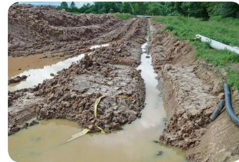
Bauarbeiten bei zu feuchten Bodenverhältnissen führen zu irreversiblen Bodenschäden! (Foto: RP Karlsruhe)
