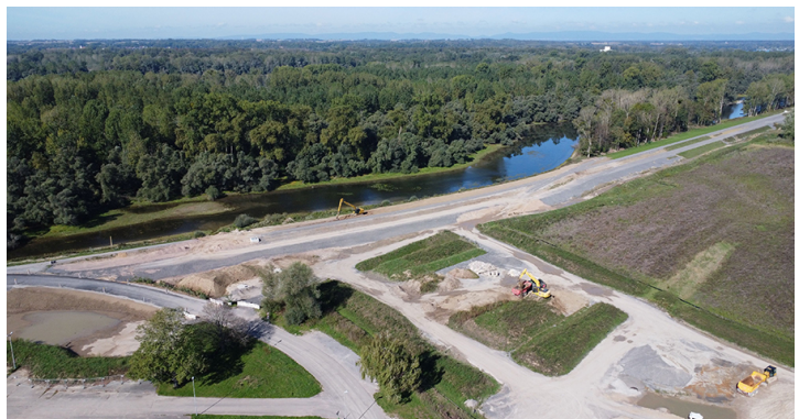
Bild 2: Aktuelle Dammbauarbeiten im Baulos 5 im Bereich der Dammüberfahrt am Sportplatz Elchesheim-Illingen, Bildquelle: wat Ingenieurgesellschaft mbH
