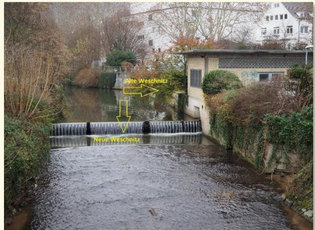
Abbildung 2: Verteilerwehr
