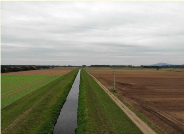
Abbildung 1: Kanalisierter und eingedämmter Flusslauf der Neuen Weschnitz
