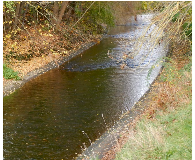
△ stark begradigter Verlauf der Würm mit Ufersicherungen (Quelle: Geitz & Partner GbR)
