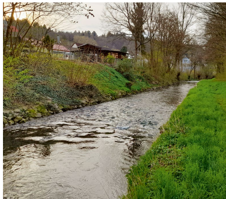
△ Die Pfinz in Remchingen: leitbildfern, begradigt, monoton und tief eingeschnitten (Quelle: we4water)
