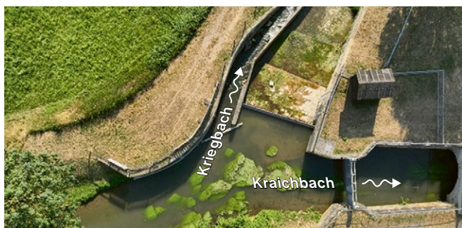
△ Abflussaufteilung am Schneidmühlwehr; der Mindestwasserabfluss in den Kriegbach verläuft über die Fischtreppe. (Quelle: RPK).
