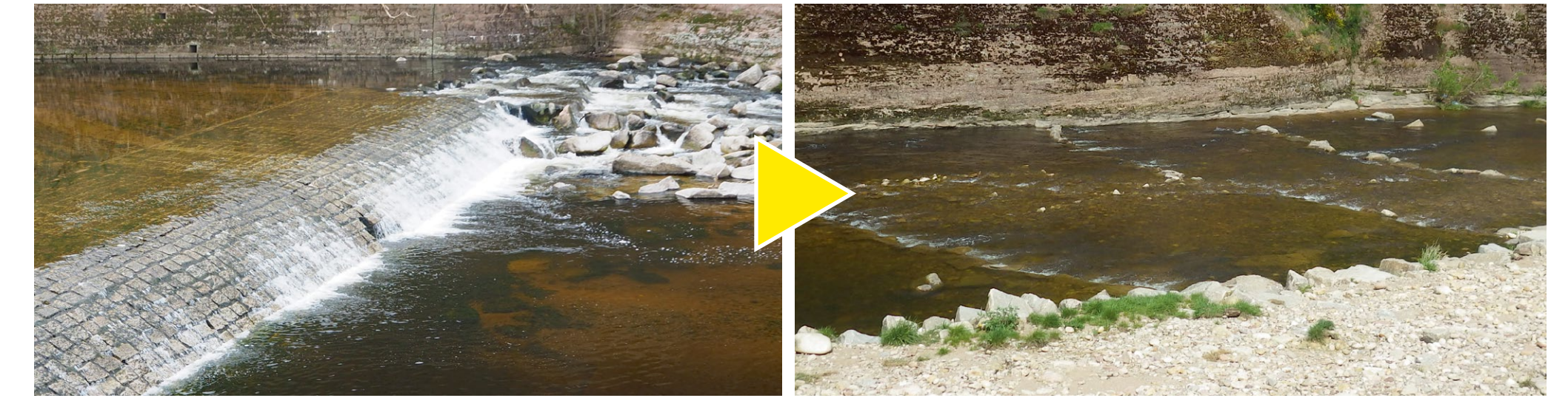
Das ursprüngliche Esselwehr (links) wurde durch eine Riegelrampe ersetzt (Fotos: RP)
